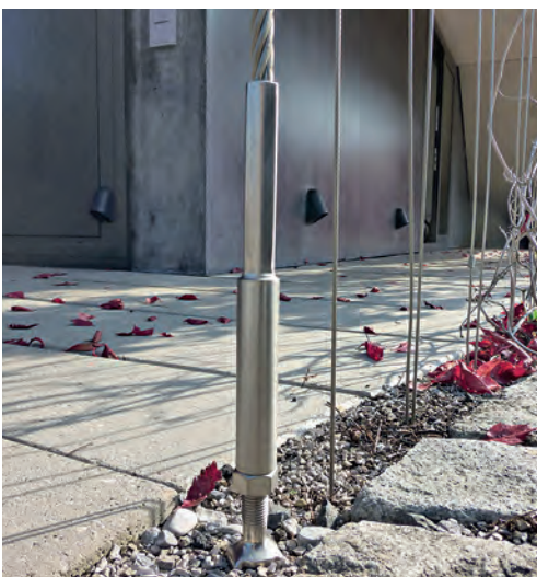
Rakennuksen kulmissa olevat pystyvaijerit on kiristetty kierretangoilla.
